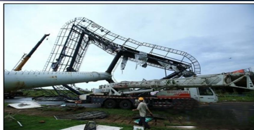
海口被刮倒的大型广告牌
